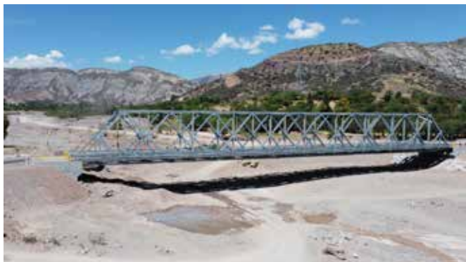
PUENTE MODULAR CHILLICOHUAYCCO
