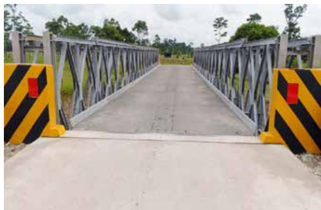
PUENTE MODULAR PUEBLO NUEVO
